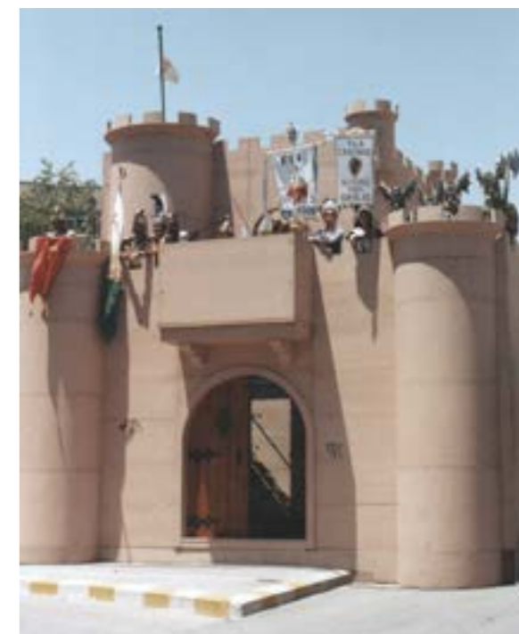
El castillo en 1989. Se observa la escalera interior
